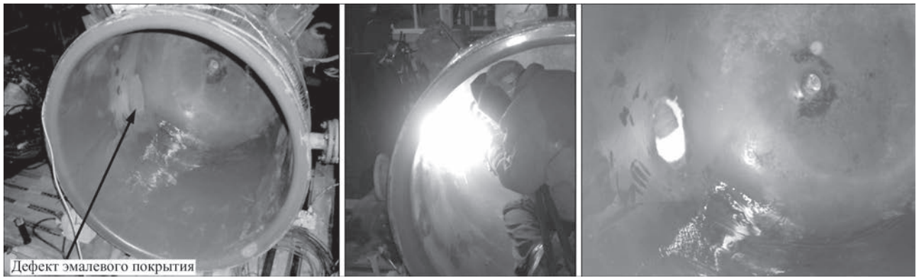
Рис. 6. Процесс восстановления локальных повреждений эмалевого покрытия реактора V-630 способом микроплазменного напыления в условиях производства
