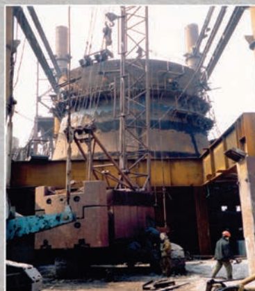
Доменная печь ДП-2 из стального проката 06Г2Б-440 на ОАО «Меткомбинат Азов-сталь»
