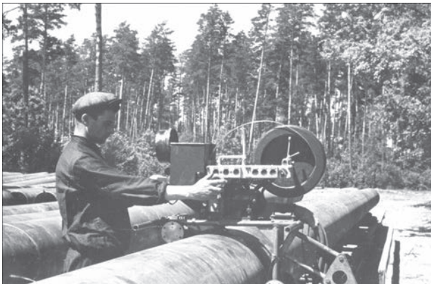
Применение технологии механизированной сварки под флюсом при строительстве газопровода «Дашава–Киев»
