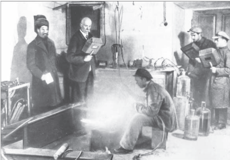
Первые эксперименты по сварке (1930 г.)
