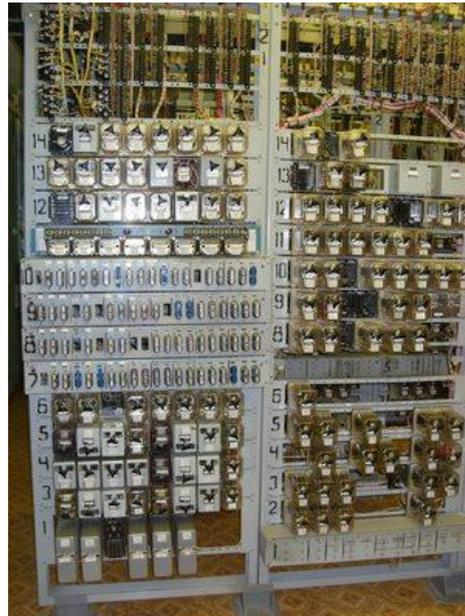
Рис. 8. Общий вид статов для размещения  $h_1$ -надежных электромагнитных реле с ВУГ в кластере К7
