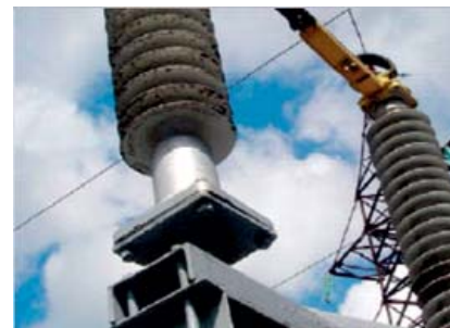
Рис. 17. Ізолятор покритий колоніями грибків
