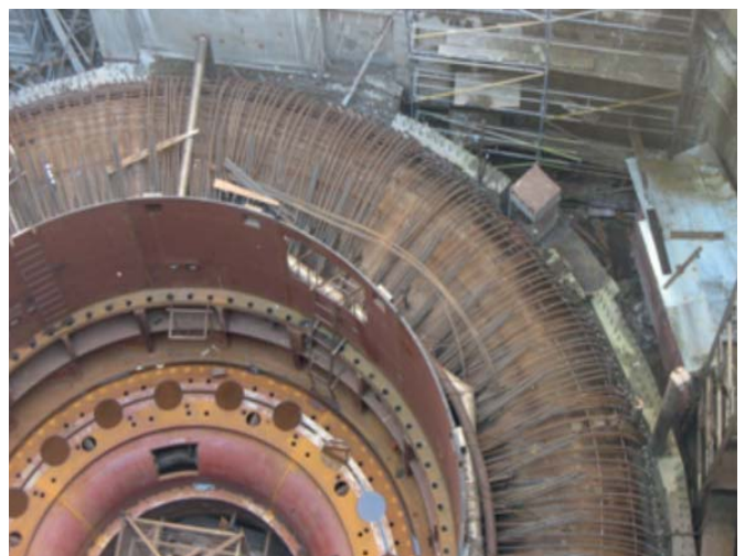
Рис. 3. Монтажні роботи по установці арматури
