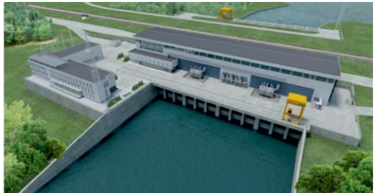
Рис. 5. Каховская ГЭС-2. Вид с нижнего бьефа
