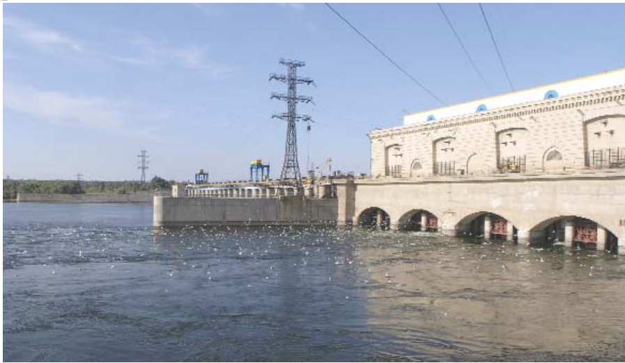
Нижний бьеф ГЭС
