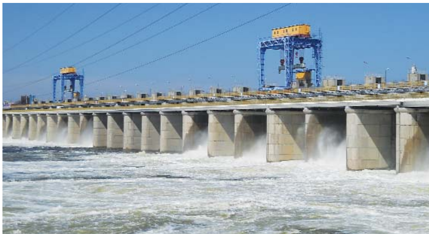
Водосливная плотина ГЭС
