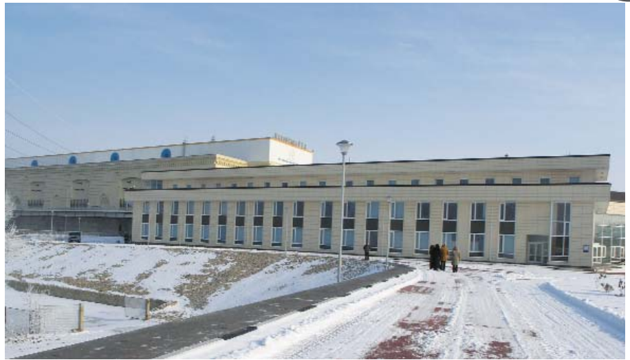
Нижний бьеф ГЭС
