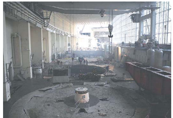
Рис. 2. Машинний зал Саяно-Шушенської ГЕС до (а) та після аварії (б) 2009 р.
