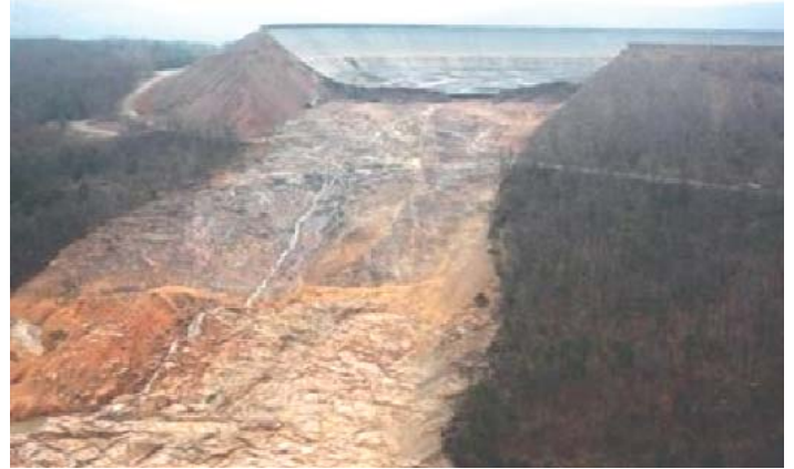
Рис. 1. Верховий басейн ГАЕС Таум Саук (США) до (а) та після аварії (б) 2005 р.
