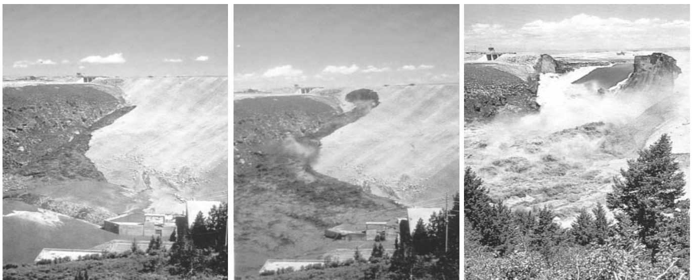
Рис. 1. Розвиток аварії на греблі Teton (США) в 1976 р.
