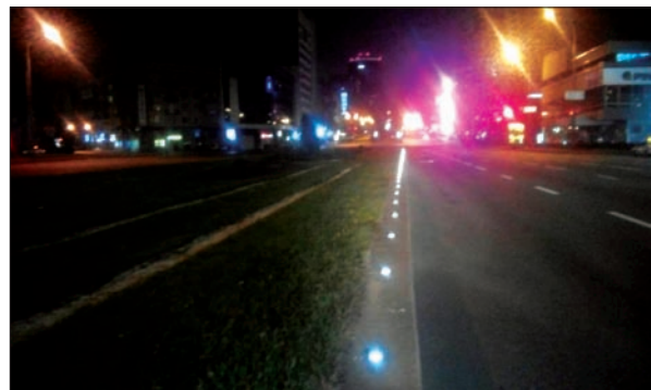
Рис. 2. Світлоповертальні елементи, встановлені на площі Перемоги в м. Києві. 2017 р.
