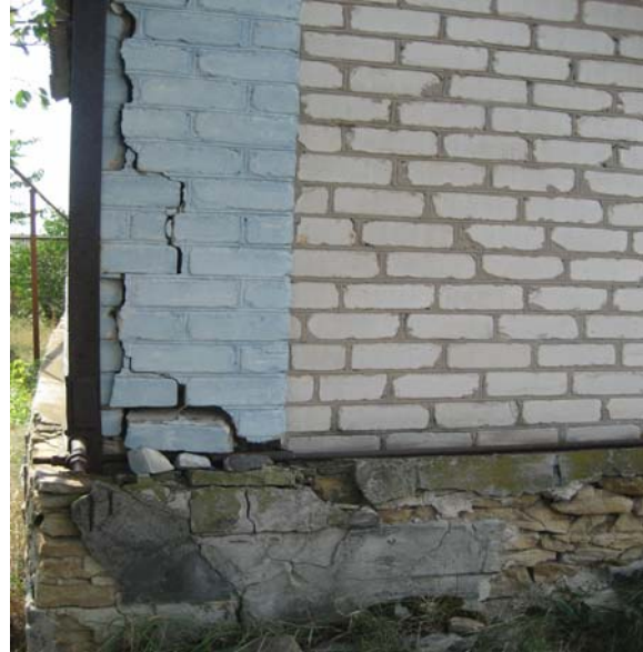
а – деформації будинку до вживання заходів захисту; б–посилення стін металевими конструкціями
