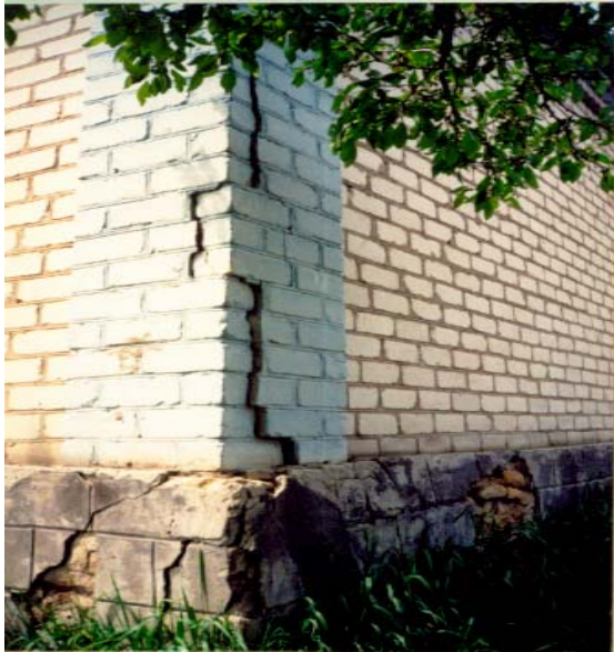
а – деформації будинку до вживання заходів захисту; б–посилення стін металевими конструкціями
