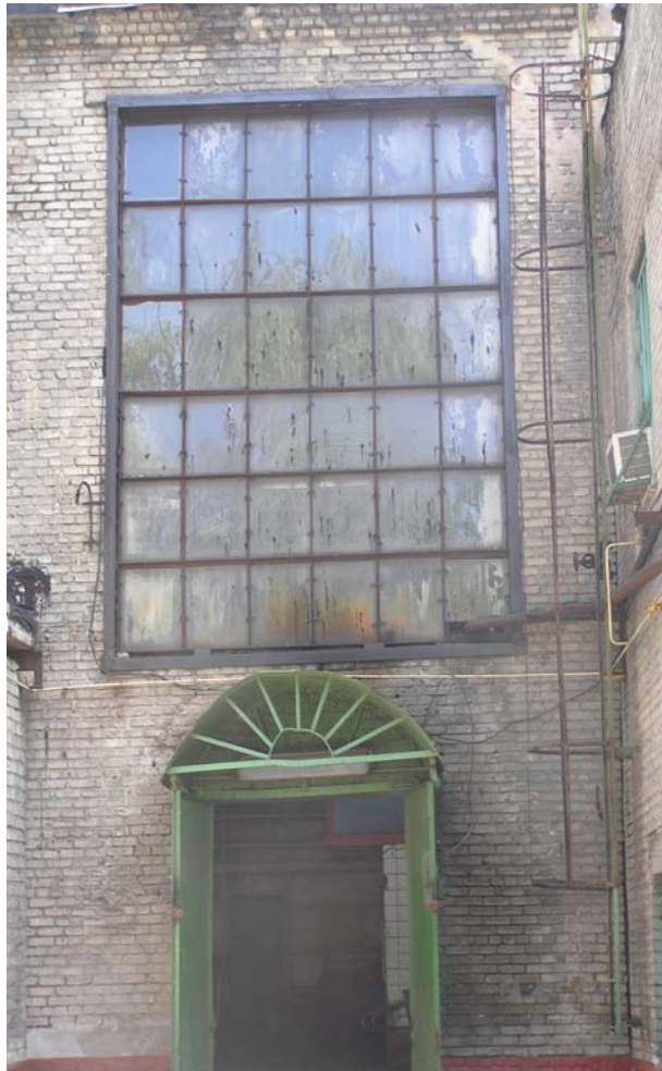
Рис. 5. Усиление оконного проёма металлической рамой в труболитейном цехе
