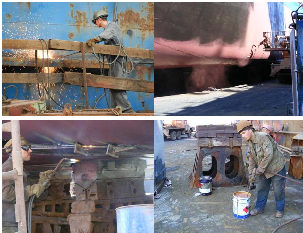
Рис. 1. Работа сварщиков и маляров при проведении ремонтных работ, связанных с нанесением противообрастающего покрытия
