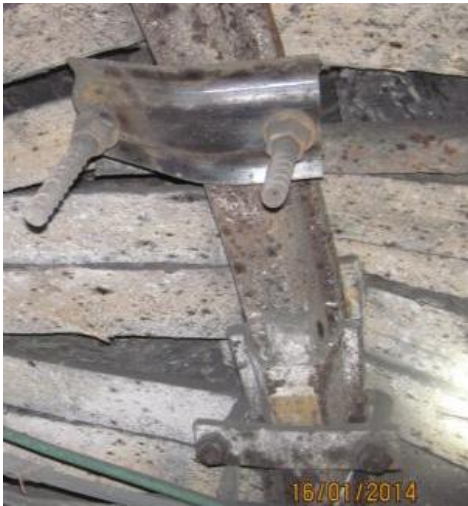
Рисунок 2 - Усиление крепи спаренными анкерами
