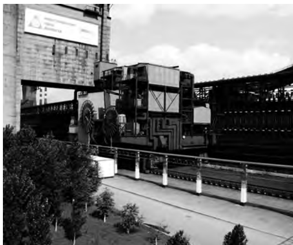
Рис.1. Коксовая батарея с технологией трамбования угольной шихты.
