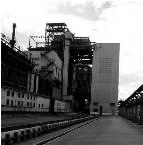
Рис.2. Установка сухого тушения кокса.
