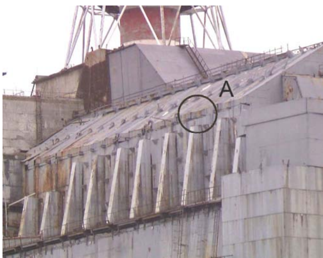
Рис. 30. Стабилизация северной части покрытия и контрфорсной стены.
