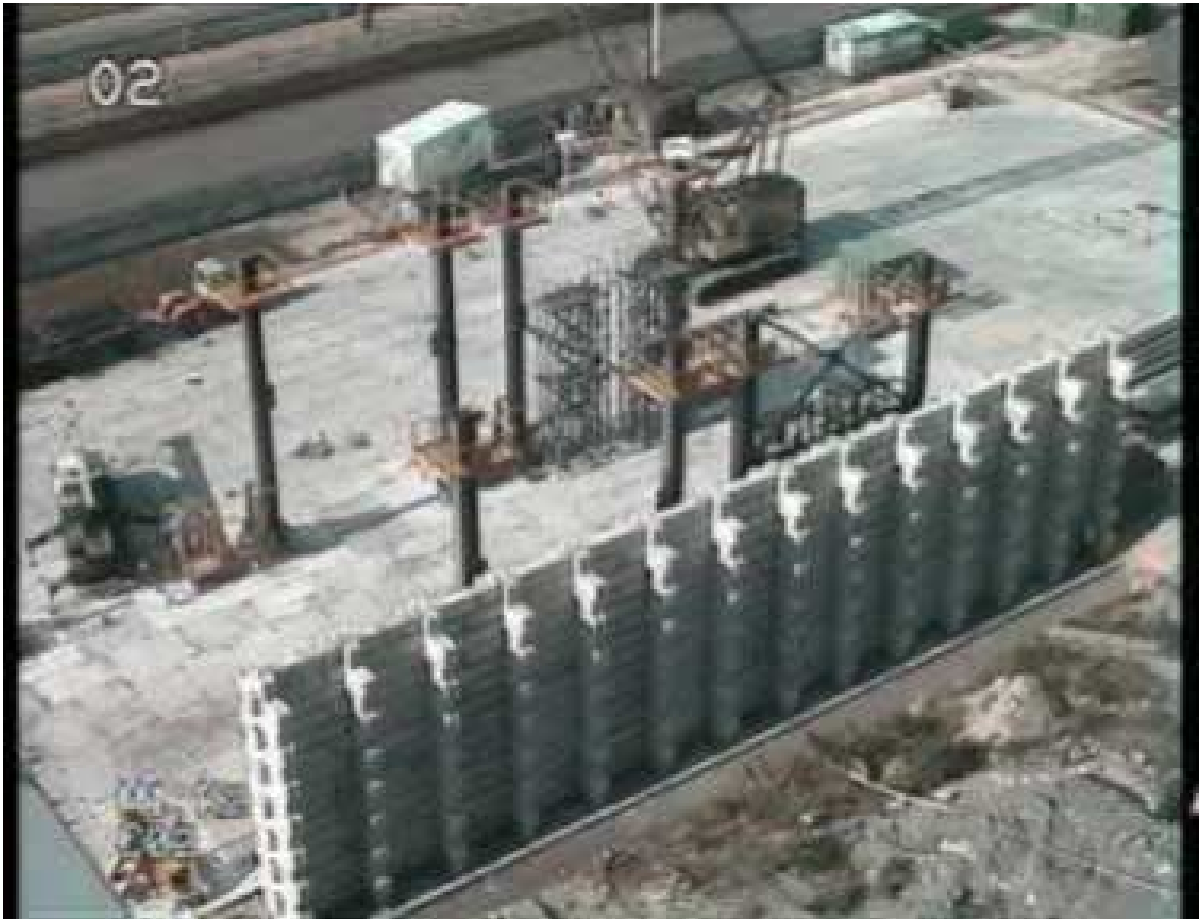
Рис. 32. Защитная бетонная стена.
