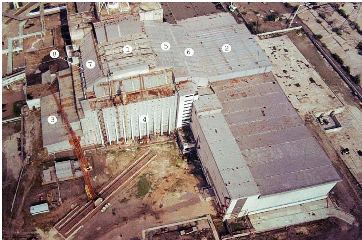
Рис. 18. Внешние ограждающие конструкции объекта „Укрытие”:
