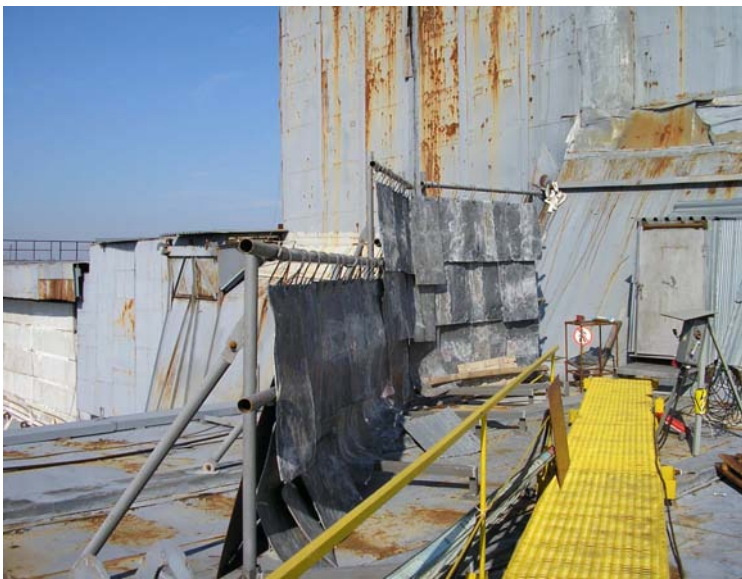
Рис. 33. Варианты экранирования: а - экранирование путей доступа к западной опоре балки «Мамонт»; б - переставная защитная кабина.
