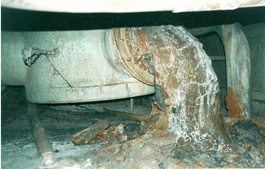
Рис. 6. Лава в паросбросном клапане парораспределительного коридора (ПРК).
