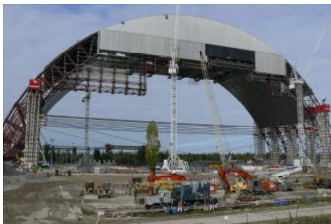
Рис. 1. Будівництво «Арки» НБК.
