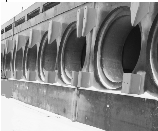
Рис. 2. Незаполненные бетонные модули хранения ОЯТ на площадке ХОЯТ-2 (2009 г.).
