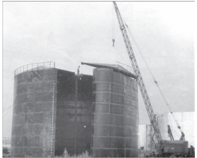
Монтаж крупногабаритного резервуара (1948 г.)
