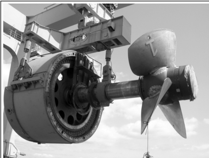
Рис. 1. Монтаж роторной части гидроагрегата Каневской ГЭС, Украина
