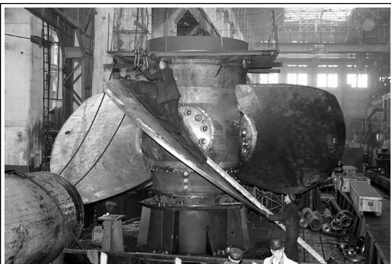
Рис. 7. Контрольная сборка рабочего колеса Каховской ГЭС, Украина
