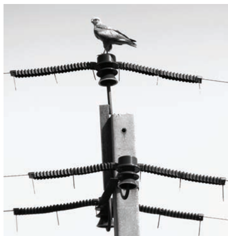
Рис. 3. Обыкновенный канюк, сидящий на пластиковом птицевозащитном кожухе ПЗУ-6-10 кВ-Л, изолирующем фазовый токоведущий провод птицепоопасной ЛЭП. (Фото О. Г. Салтыковой).
