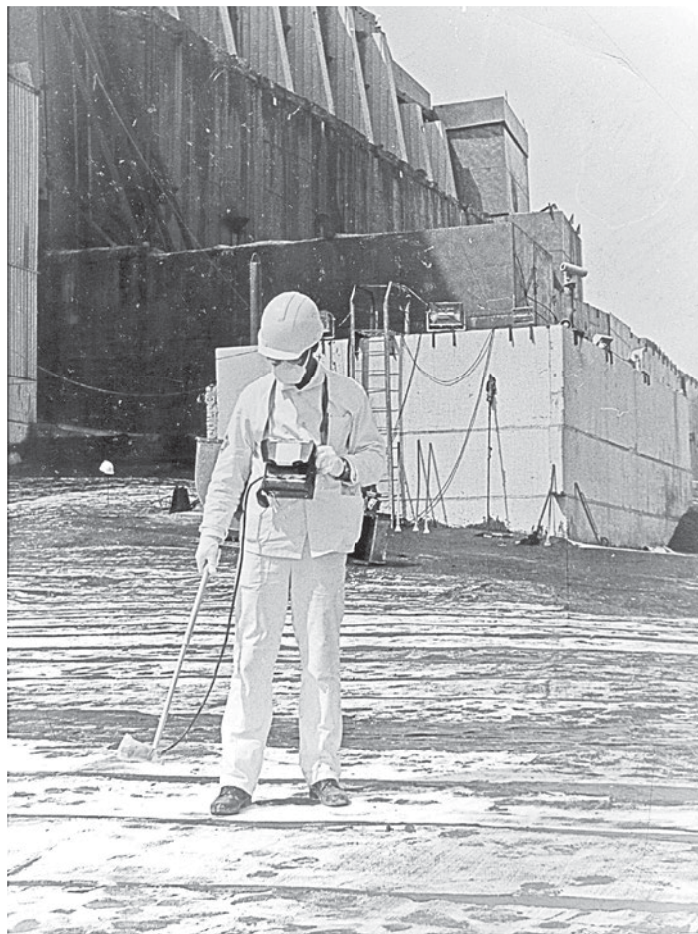
Радиационный контроль новой кровли ВСПО
