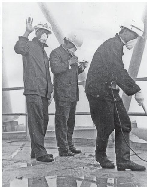
Радиационное обследование площадок венттрубы ВТ-2
