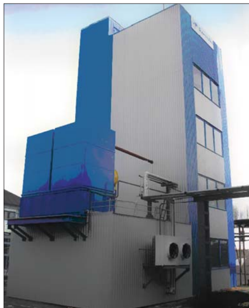
Станція зневоднення етанолу потужністю 100 м 3 на добу на Хоростківському спиртзаводі. ТОВ «Виробнича група «Техінсервіс»
