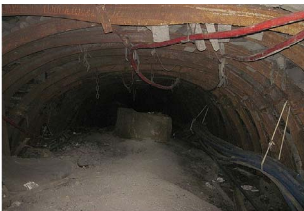
Рисунок 2. Образование клина выдавливания пород кровли (а) и почвы (б) в условиях шахты “Белозерская”
