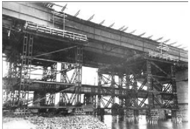
Рис. 14. Общий вид сварного монтажного стыка в пролете
