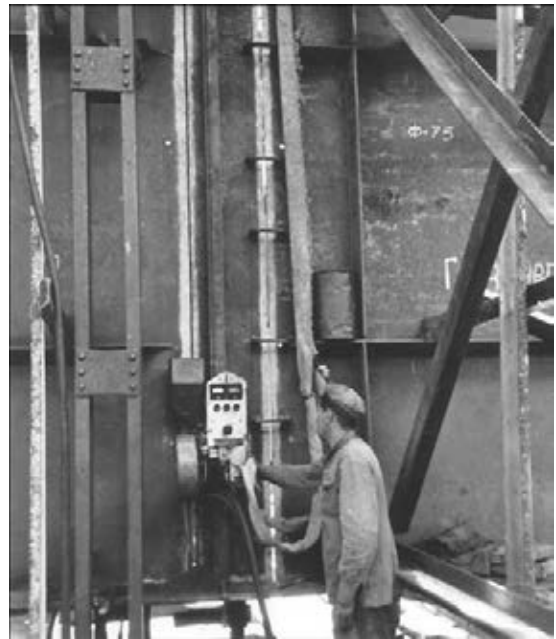
Рис. 13. Сварка вертикального монтажного стыка автоматом А-314
