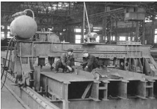
Рис. 2. Общий вид траверсы кондуктора для сборки и сварки крупногабаритных монтажных элементов в цеху ЗМК
