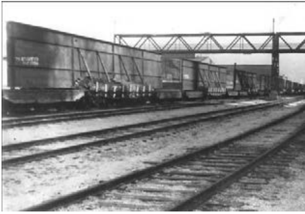
Рис. 11. Эшелон с главными балками на заводских путях
