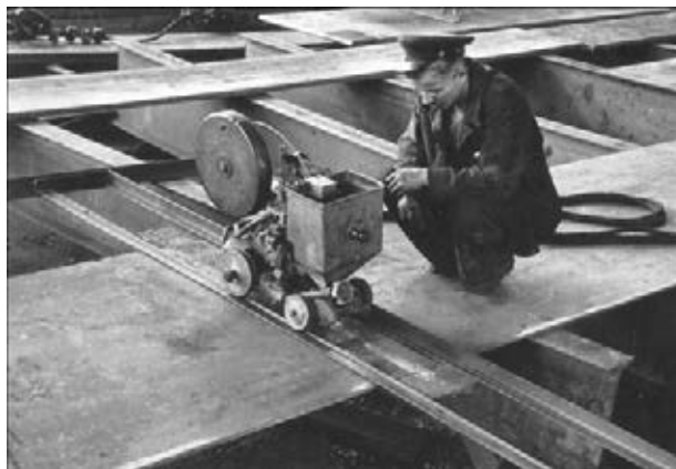
Рис. 5. Сварка трактором ТС-17-М стыкового шва стенки
