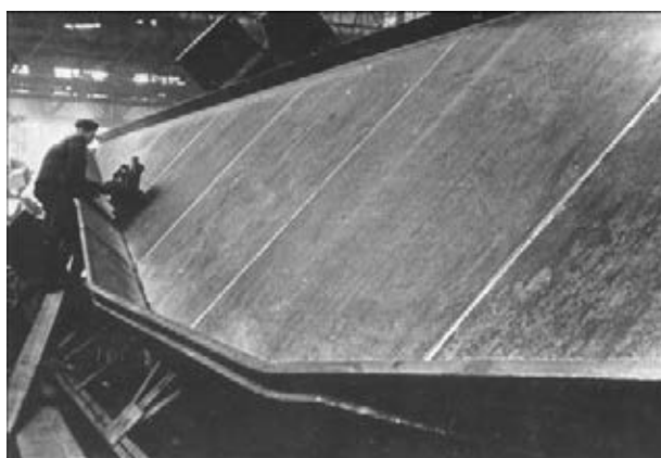
Рис. 9. Сварка поясных швов вута в кондукторе
