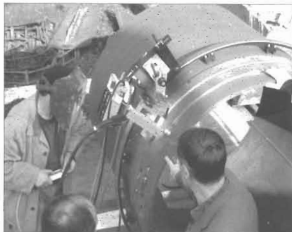
Автоматическая сварка неповоротных стыков — система Orbital Railtrac
