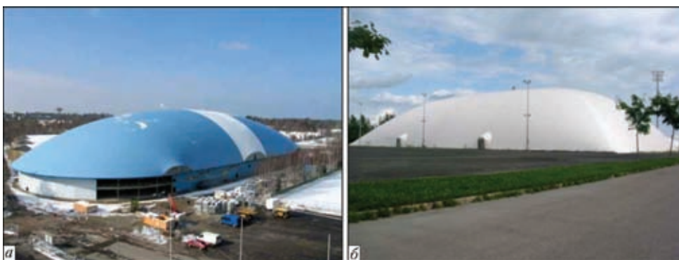
Рис. 5. Варианты конфигурации воздухоопорных конструкций компании «Вингида», Финляндия—Латвия [5]
