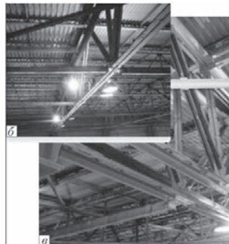
Рис. 8. Усиление дефектных металлических стропильных ферм покрытия пролетом 45000 м: а – проектное решение по усилению конструкций; б – общий вид до усиления; в – во время усиления
