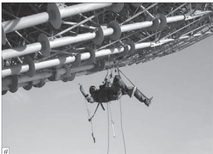
Рис. 1. Обследование металлических конструкций спецсооружения с помощью мобильного диагностического комплекса методом промышленного альпинизма (а) и общий вид сооружения после окончания ремонтно-восстановительных работ (б)
