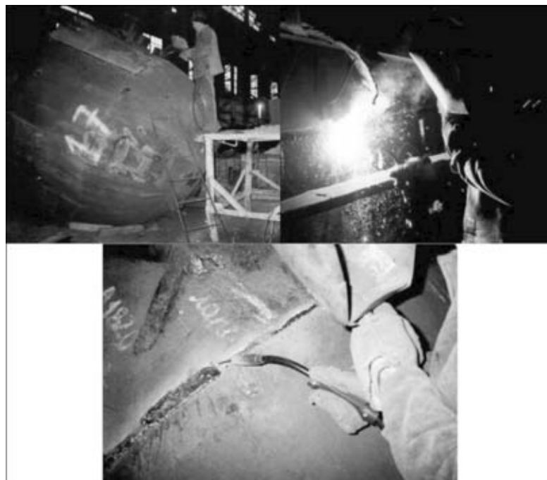
Рис. 5. Ремонтная сварка порошковой проволокой ПП-АН7 металлургического оборудования на Днепропетровском металлургическом комбинате
