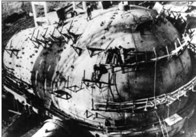
Рис. 4. Общий вид монтажа воздухонагревателя
