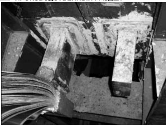
Рис. 7. Соединение плата – блюмс до (справа) и после (слева) сварки
