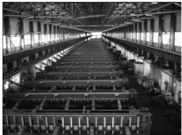
Рис. 1. Строящийся цех № 9 Иркутского алюминиевого завода
