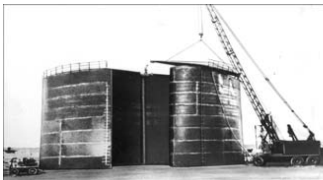
Монтаж резервуара вместимостью 10 тыс. м 3 из рулонированных конструкций
