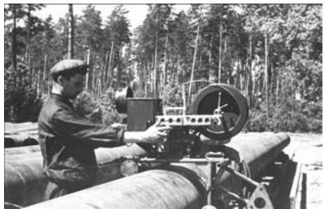
ТС-17 на полевом стане газопровода Дашава – Киев
