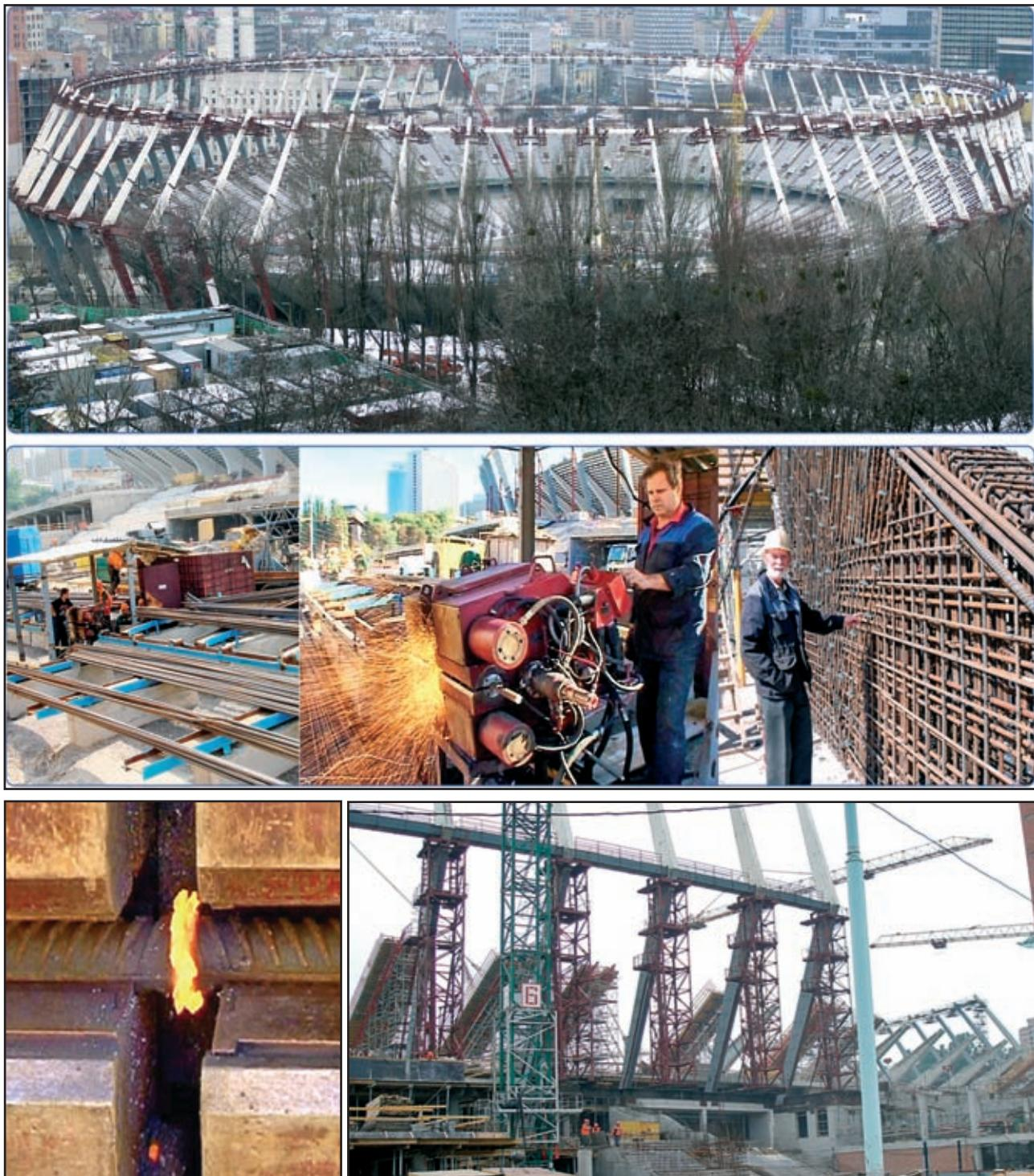
Сварочный комплекс включает ранее созданные в ИЭС им. Е. О. Патона мобильные контактные стыковые машины. С помощью предложенной технологии и оборудования выполнен большой объем работ по контактной стыковой сварке стержневой арматуры железобетона диаметром 20, 25, 28, 32 и 36 мм для изготовления двадцати ригелей верхнего яруса зрительских трибун VIP-зоны и монолитных плиты подъезда.
