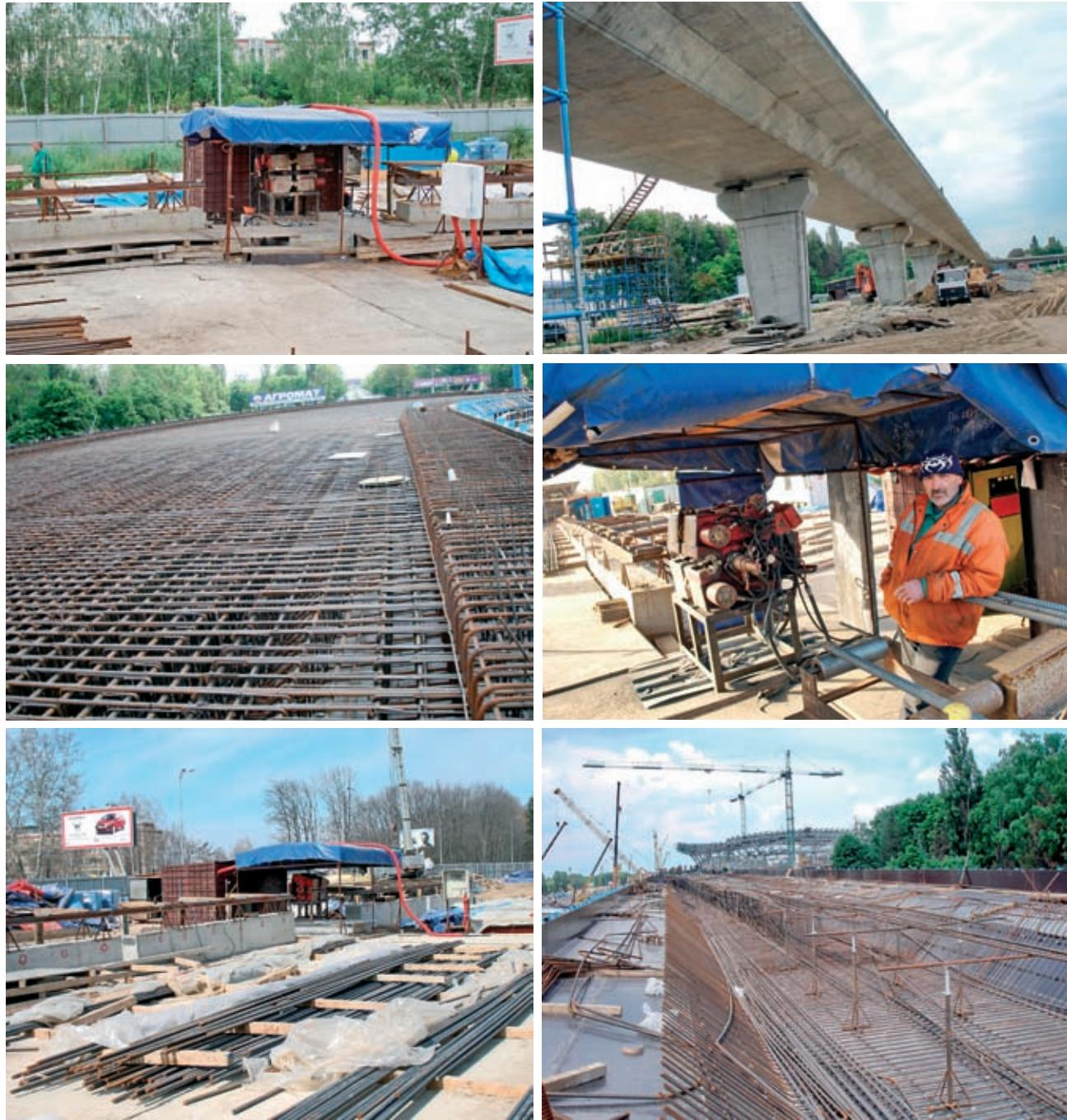
Контактная стыковая сварка отличается высоким стабильным качеством сварных соединений, практически равнопрочных с основным металлом, что позволяет существенно повысить надежность и эксплуатационный ресурс железобетонных конструкций и обеспечить высокую производительность. Процесс сварки происходит в автоматическом режиме, совмещает в едином цикле сборочные и сварочные операции, не требует применения вспомогательных расходных материалов.
