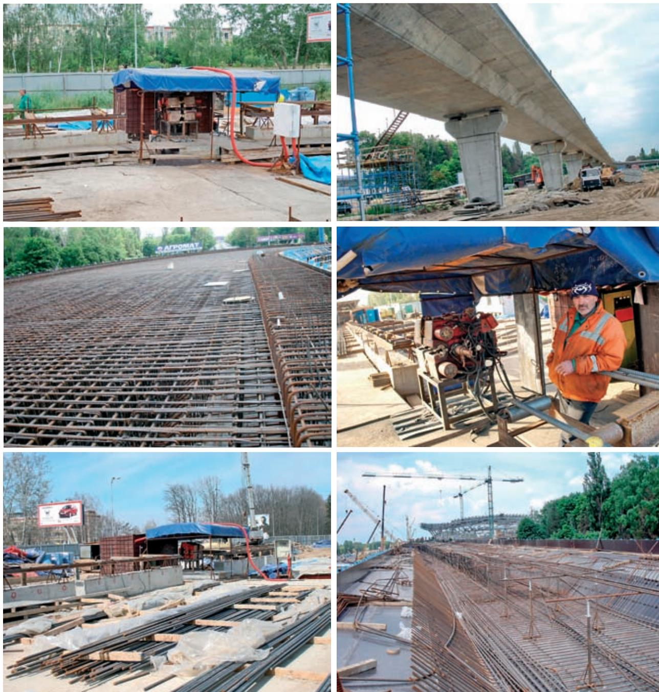
В течение апреля — октября 2011 г. с помощью предложенной технологии и оборудования была выполнена сварка около 30 тыс. т арматуры диаметром 32 мм при строительстве подъездной эстакады терминала D аэропорта «Борисполь» протяженностью порядка 2 км.
